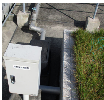
◀植栽の維持のために設置された自動灌水装置
